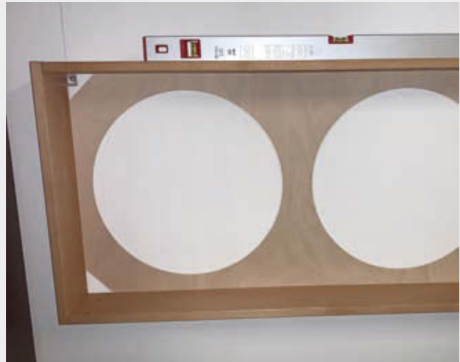
5. Der Wechselrahmen sollte mit der Wasserwaage für eine korrekte Ausrichtung kontrolliert und ggf. korrigiert werden
