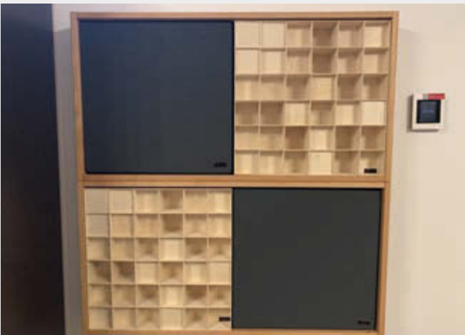
7. Bestückungsvariante mit je einem Diffusor und einem Absorber pro Wechselrahmen. Die Akustikmodule werden dabei ohne weitere Befestigung in den Rahmen eingesetzt
